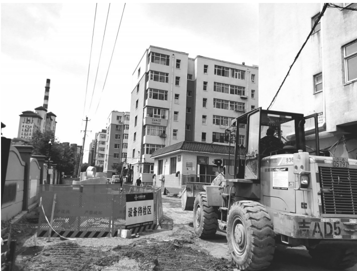
松宇花园小区施工现场 本组图片城市晚报全媒体记者 刘佳雪 摄
