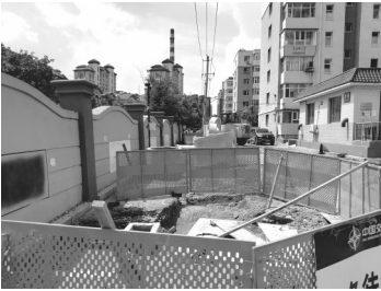
改造工程近期陆续完工
