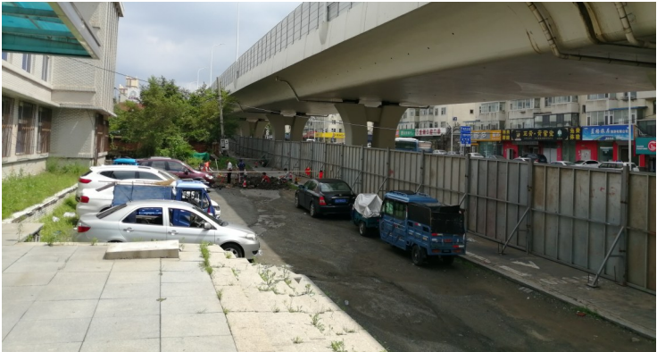
现场工人正在挖“深沟”
