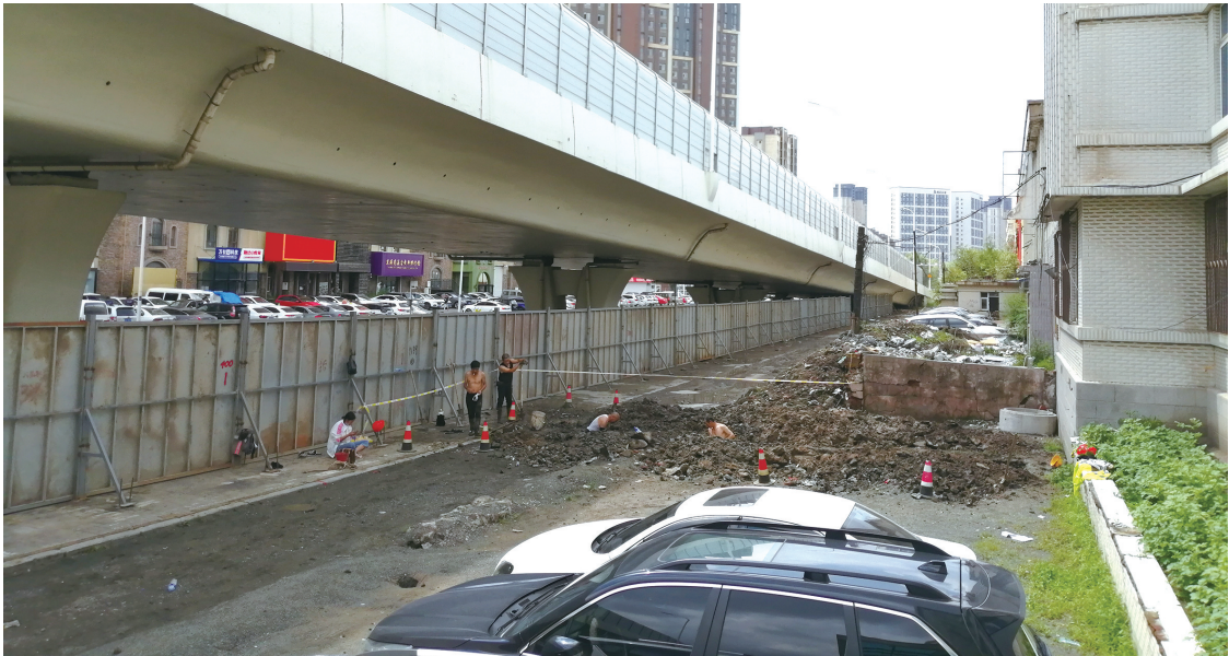
现场工人施工中 城市晚报全媒体记者 刘佳雪 摄
