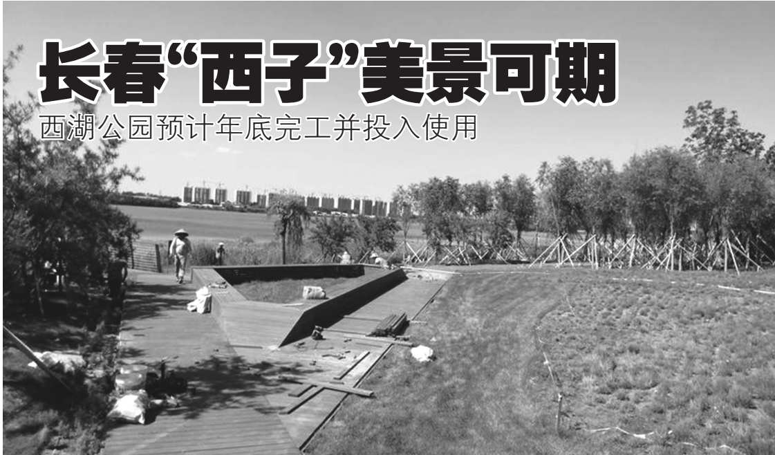
工人正在施工 本组图片 城市晚报全媒体记者 刘佳雪 摄
