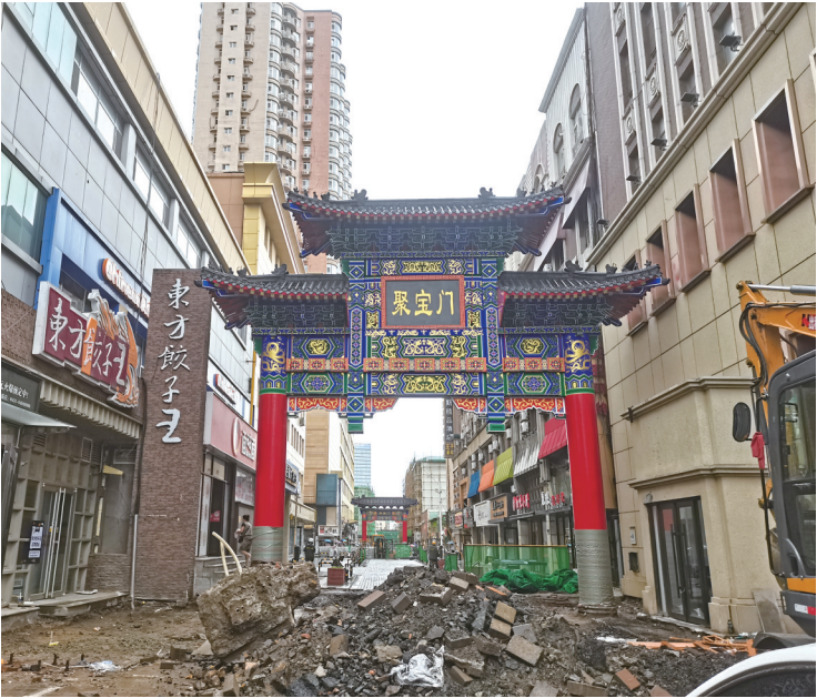
重庆胡同改造现场 城市晚报全媒体记者 陆续 摄
