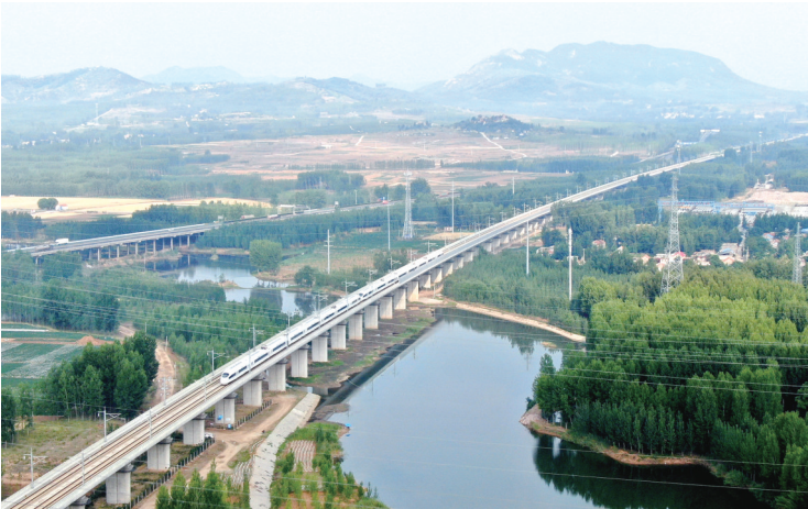
6月19日,一列动车组列车在山东省临沂市平邑县境内行驶(无人机照片)。 新华社发 武纪全 摄
