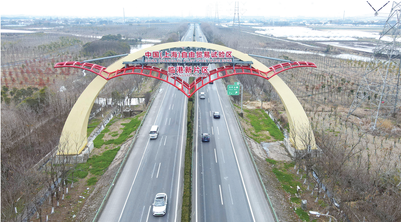
S2沪芦高速上的中国(上海)自由贸易试验区临港新片区“海鸣门”(2022年2月10日摄,无人机照片) 新华社记者 方喆 摄
