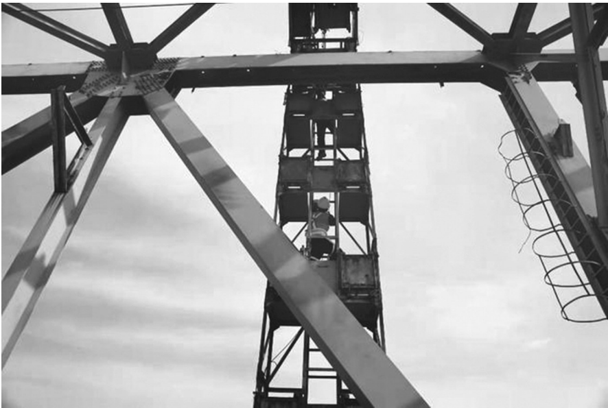
刘正东和工友通过天车一侧的检查通道,检查钢梁桥中部高强度螺栓 新华社发 王占军 摄
