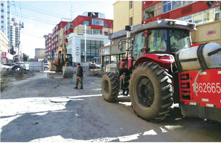
现场正在施工作业
