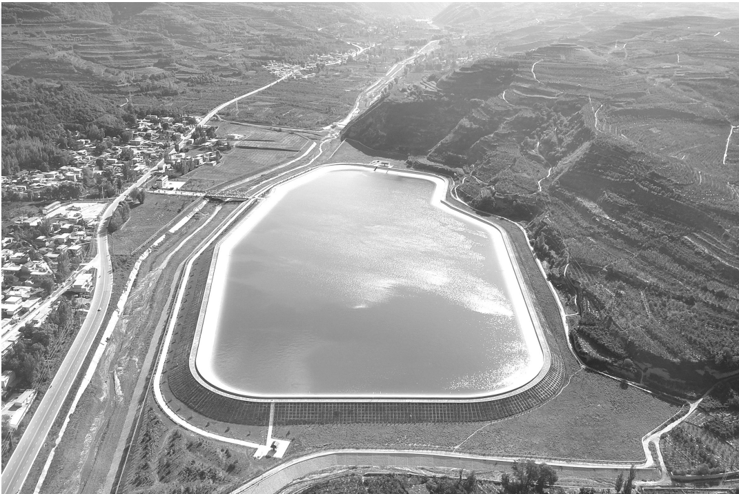
这是9月8日在天水市拍摄的已投用的天水城区引洮供水工程杨家湾调蓄水池(无人机照片)。
