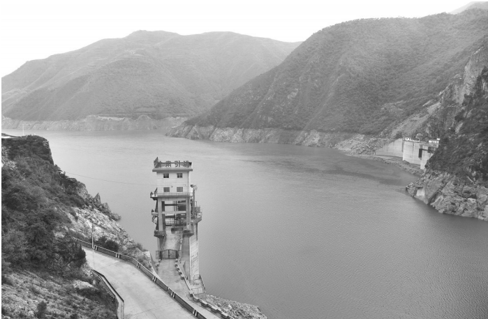
这是9月3日在甘肃省卓尼县藏巴哇镇境内拍摄的九甸峡水利枢纽引洮工程取水口。
