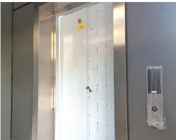
一楼电梯门仍然紧闭
