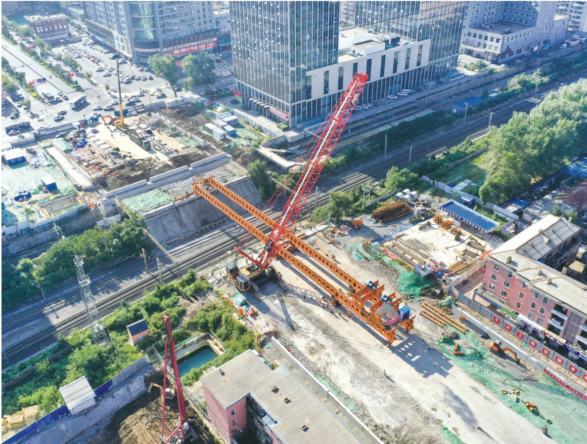
9月2日,架桥机完全撤出了西安桥的施工区域
