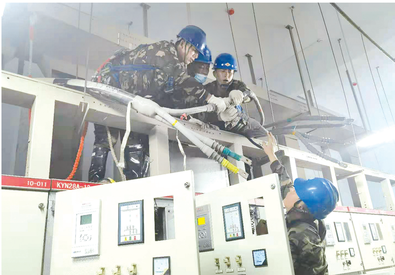
国网白城供电公司抗洪援豫队员在马小营小区开闭室开展恢复送电施工。/勾丽娜 记者 李彤君 孟凡秋 报道 摄
