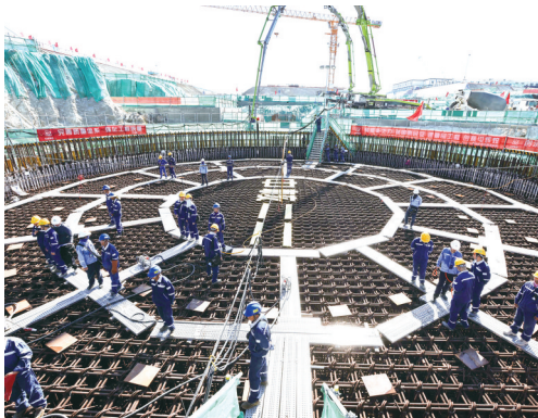
7月13日,工人在海南昌江“玲龙一号”施工现场工作。 /新华社记者 张丽芸 摄
