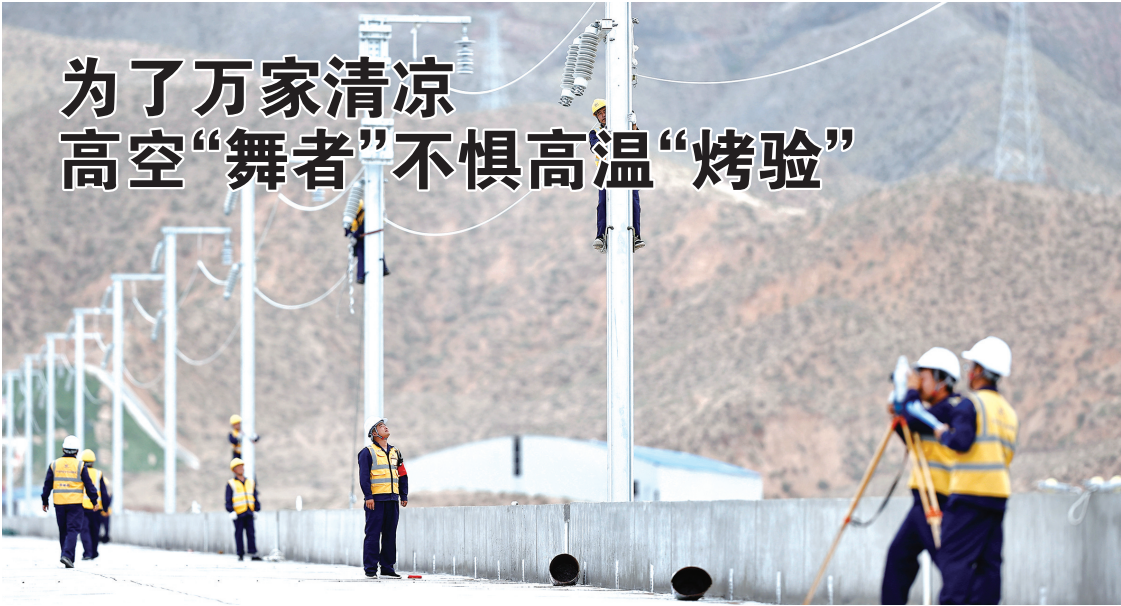
中铁电气化局三公司的工作人员在中兰客专(宁夏段)宁夏中卫市境内进行接触网施工作业(7月10日摄)。
