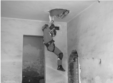
建筑倒塌,打通楼板,利用绳索转移人员
