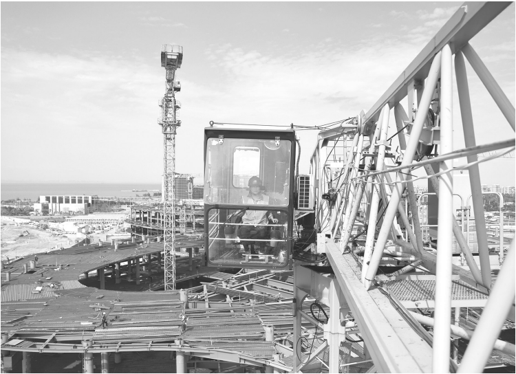
3月5日,海口国际免税城项目上的塔吊司机杨玉连在操作塔吊
