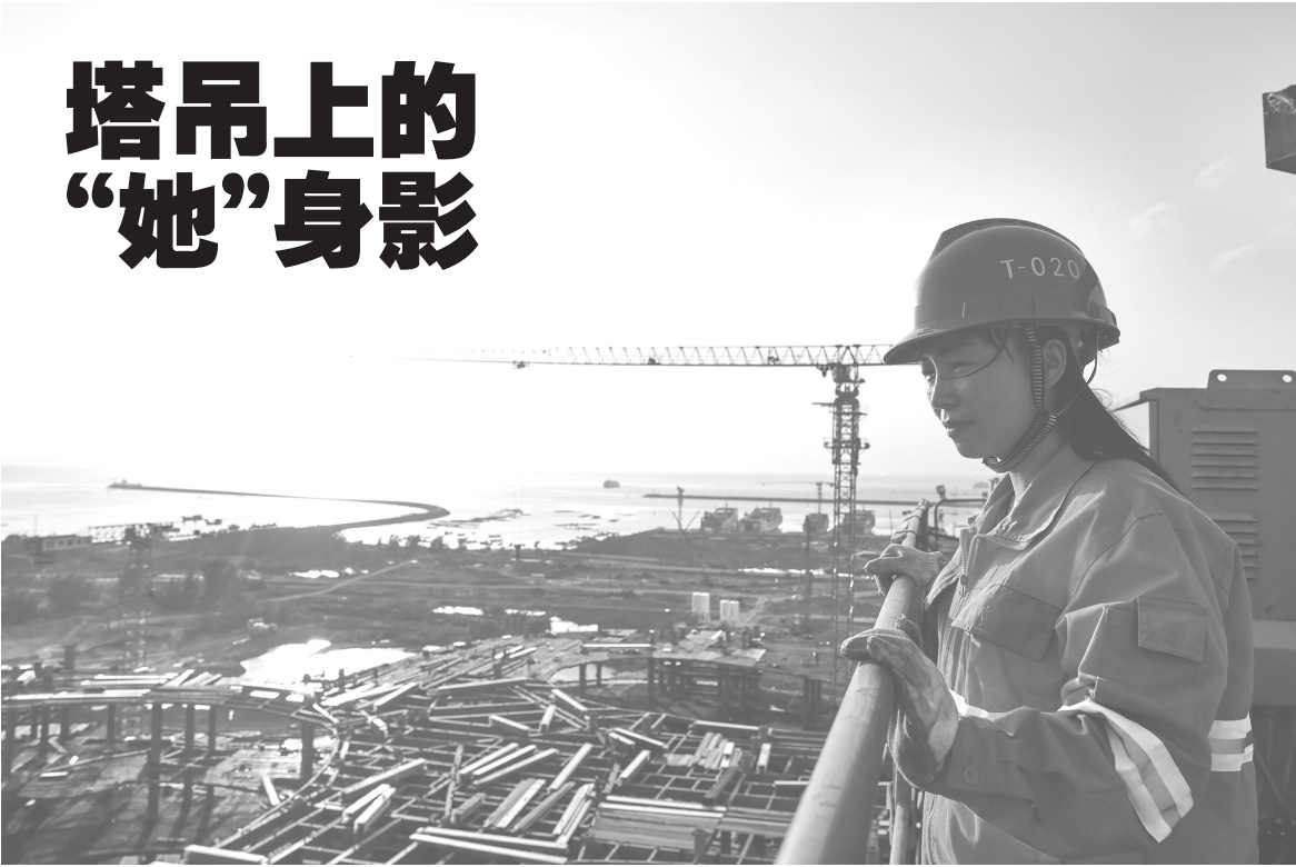
3月5日,海口国际免税城项目上的塔吊司机吕红慧在眺望工地
