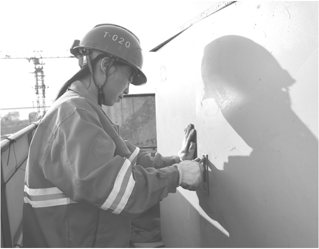
3月5日,在海口国际免税城项目工地,塔吊司机吕红慧在进行班前检查
