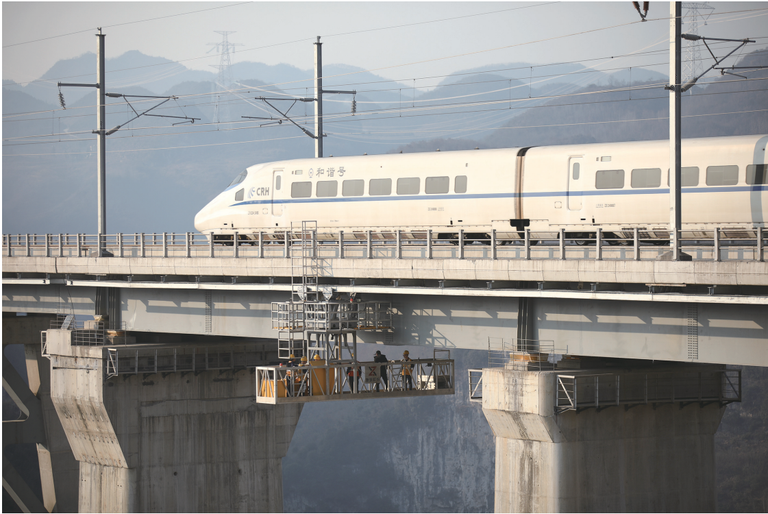
1月19日，贵阳高铁工务段毕节桥路车间工人在西溪河大桥下进行检查作业。成贵高铁西溪河大桥横跨贵州省毕节市乌蒙山的西溪河大峡谷，这里山高谷深、地势险要，桥面至河面高差达250多米，冬季常有凝冻现象，寒风更是凛冽刺骨。为保障每天数十趟高铁动车组的安全通过，贵阳高铁工务段职工们克服了海拔高、气候恶劣等困难，在250多米的高空中对大桥进行体检，全力确保行车安全。
