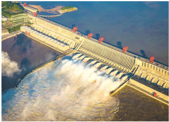
长江三峡水利枢纽工程开启泄洪深孔泄洪
