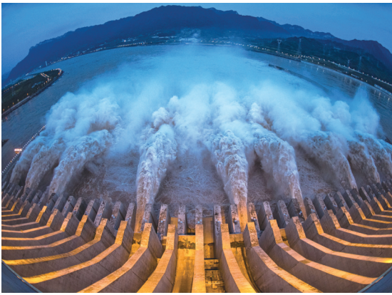
长江三峡水利枢纽工程开启泄洪深孔泄洪
