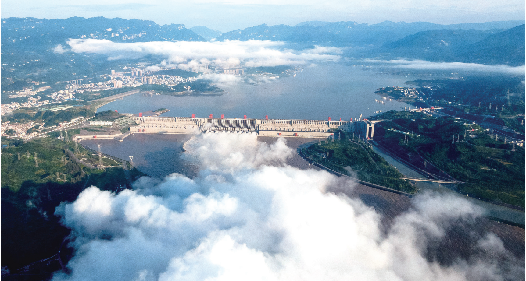
长江三峡水利枢纽工程开启泄洪深孔泄洪
