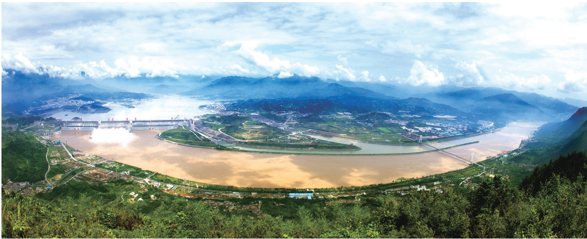
2009年8月6日拍摄的三峡大坝
