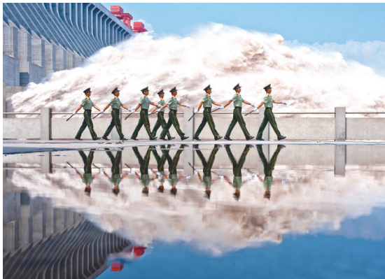
2012年7月24日拍摄的三峡大坝
