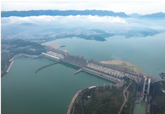
2020年11月1日拍摄的三峡大坝
