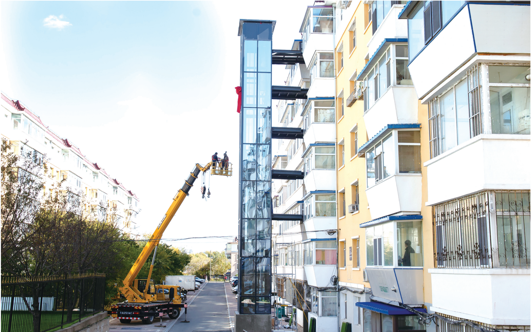
邮电小区15栋电梯正在施工
