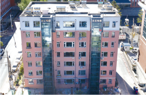
老干部宿舍电梯正在施工
