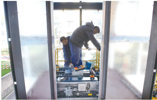
施工工人正在邮电小区安装电梯
