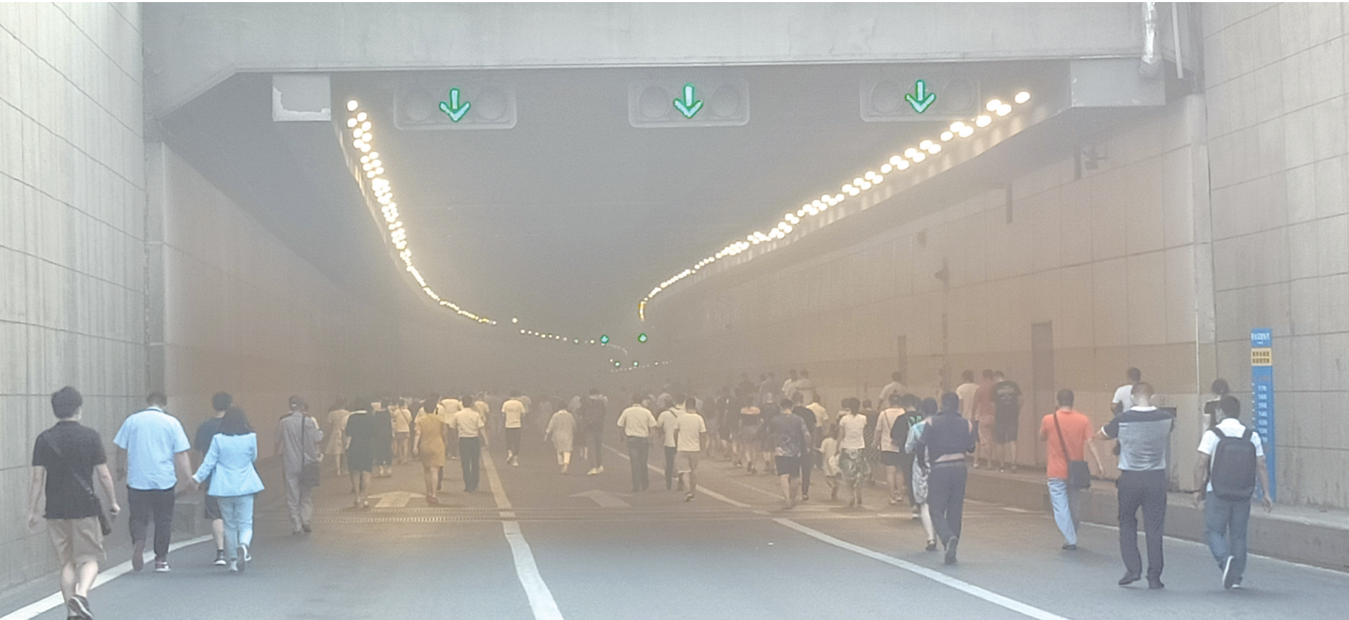
险情排除后,大家返回隧道取车
