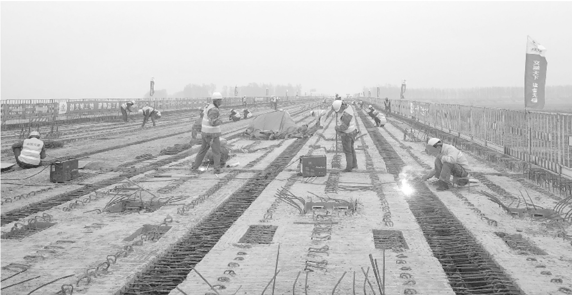
饮马河大桥施工现场
