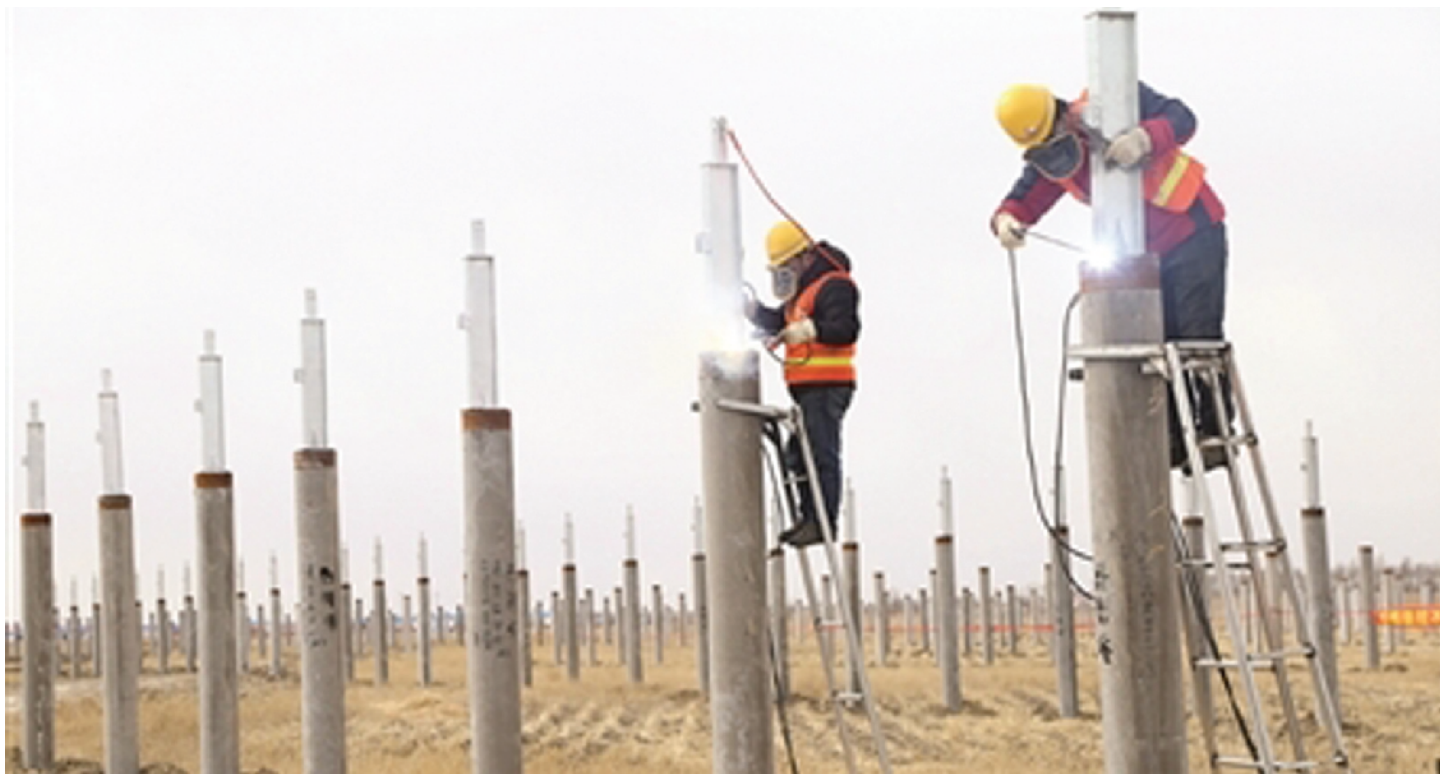
工人正在焊接光伏组件基础支架。/ 张殿文 摄
