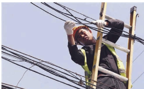
线路维修工人在高空作业
