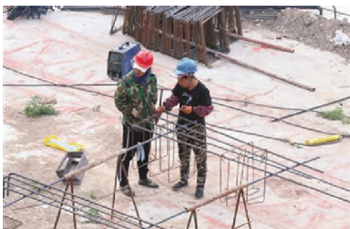
建筑工人头顶烈日坚持工作
