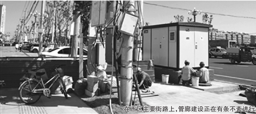
在市区主要街路上,管廊建设正在有条不紊进行
