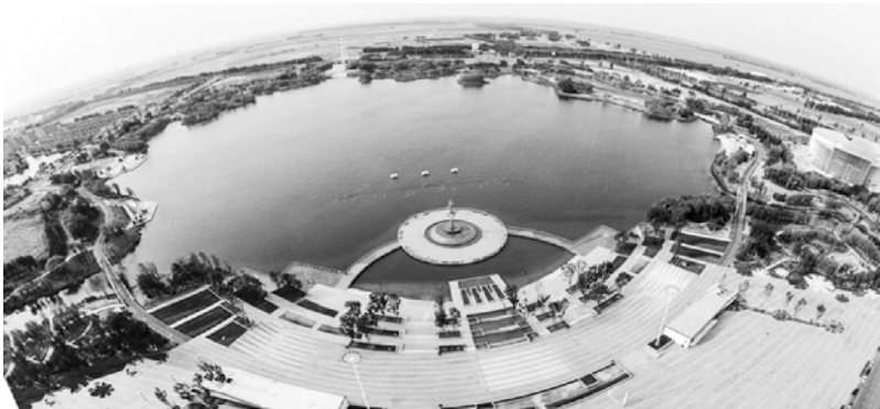
水系样板:鹤鸣湖多功能调蓄水体项目
