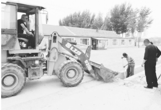
国网吉林省电力有限公司通榆县供电公司驻村帮扶工作在鸿兴镇绿化村清理排水沟
