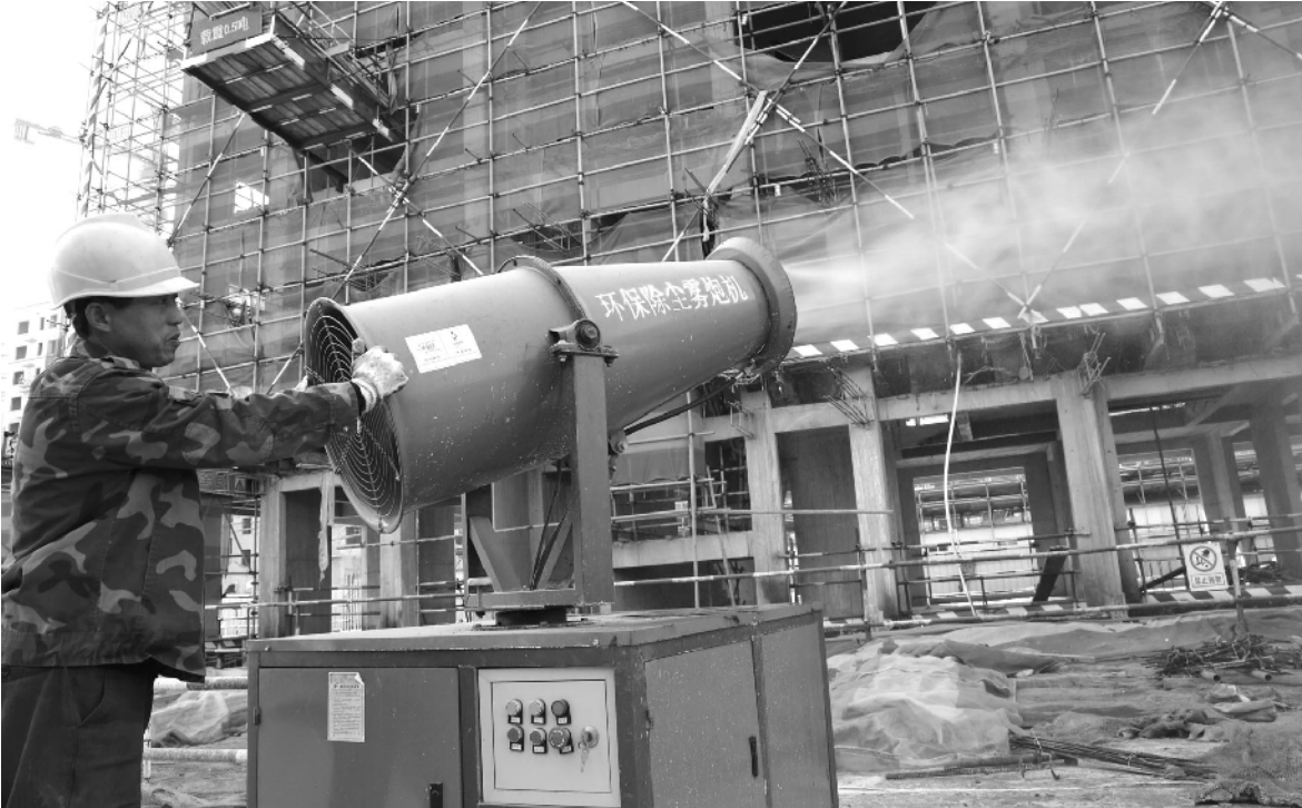
11月5日,在山东省滨州市博兴县一处建筑工地,一名建筑工人操作“环保除尘雾炮机”降低施工现场扬尘污染。 为有效减少建筑工地扬尘,博兴县开展“六个百分百”扬尘污染专项治理,即“施工区域100%标准围挡、裸露黄土100%覆盖、施工道路100%硬化、渣土运输车辆100%密闭拉运、施工现场出入车辆100%冲洗清洁、建筑物拆除100%湿法作业”。 /新华社
