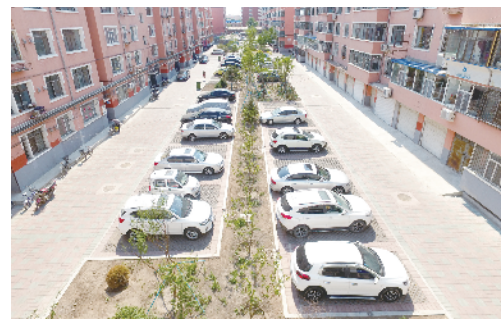
改造完成的白鹤小区
