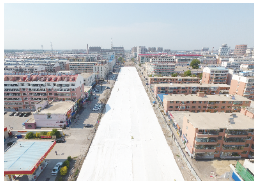
紧张作业的幸福街现场
