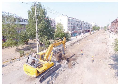
文化路施工现场
