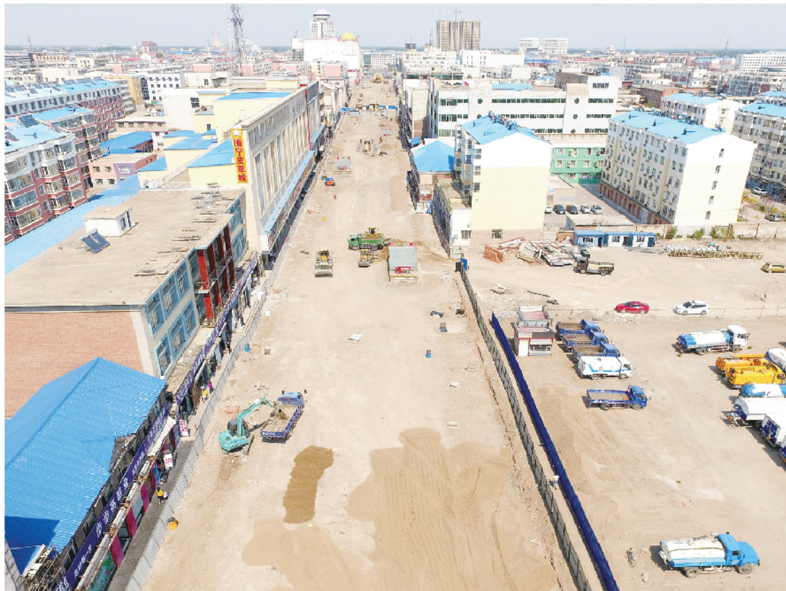
海明路步行街改造现场
