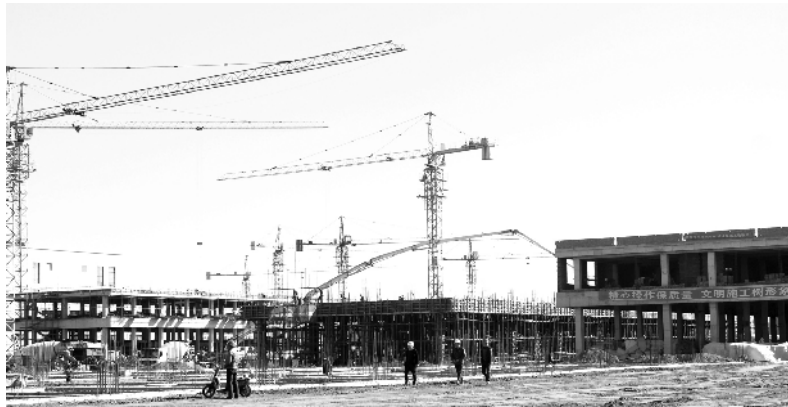
白城经济开发区居然之家综合体项目开工现场
