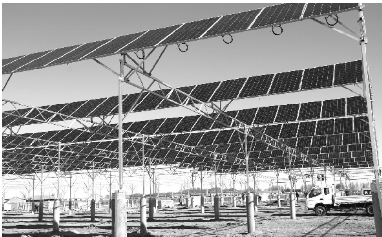
镇赉县投资3.2亿元的82个贫困村光伏扶贫项目
