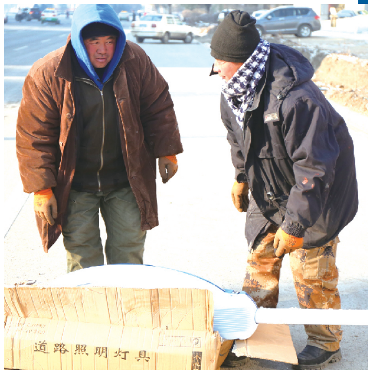
安装交通信号灯的工作人员
