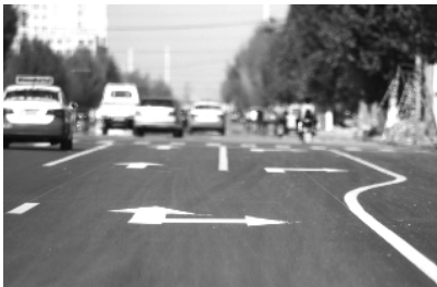
在接近“三进四出”路口时,通过道路边线及车道分隔线的弯曲,形成了第四条车道。
