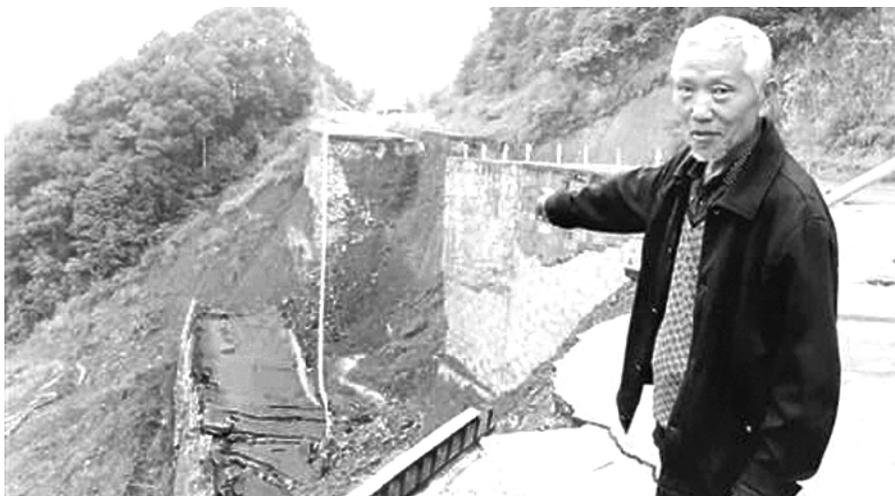
6月26日至28日,浩口乡持续大雨。28日一早,饶大爷发现武务路K24+100米处,路基塌陷,堡坎外移1米远,有垮塌的迹象。饶大爷告诉记者,这里每天过往的货车、客车、小车、摩托车达2000多辆,路面上还有两辆油罐车停了好几个月,“外边是100米深的悬崖,真要是垮了,后果不堪设想。”
