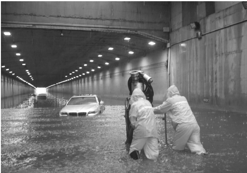
20日,北京排水集团的工作人员在北京西北广场前主路隧道进行紧急排水作业
