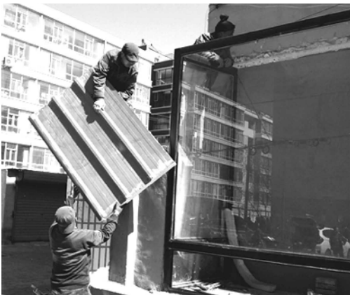
洮北区明仁街道老月华小区拆违现场
