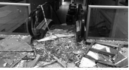
地震发生后，一建筑内部瓦砾遍地
