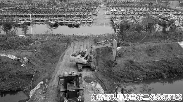
舟桥部队开辟出第二条救援通路
